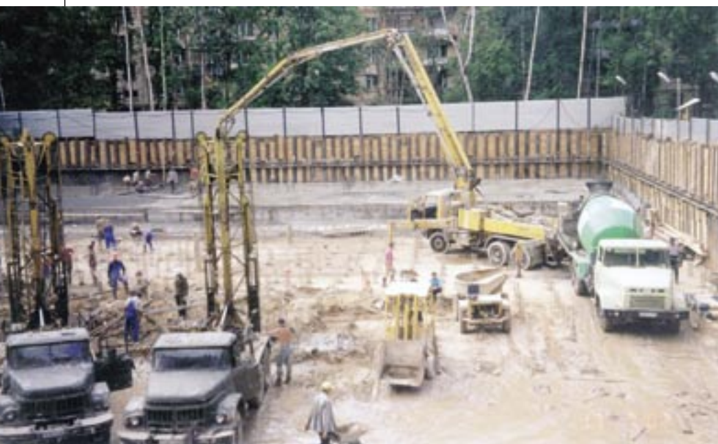
Устройство буронабивных свай и фундаментной плиты при строительстве дома по Врачебному проезду.
